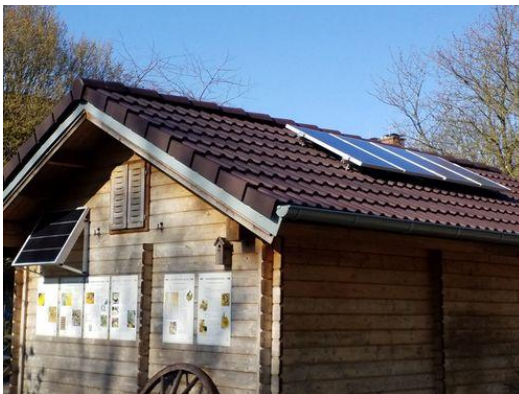
Das Hexenhaus hat eine Solaranlage.
